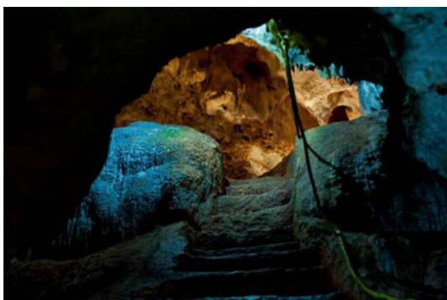
Figura 102.- Detalles de la iluminación y escalinatas de concreto. Se observa el cable de luz que cuelga.
