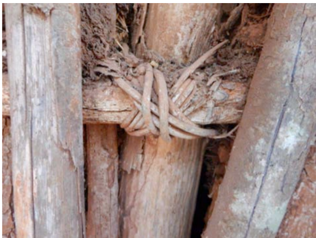
Figura 128.- Bajareque y bejuco, parte del sistema constructivo de la arquitectura vernácula de la región. Foto: Fátima Tec.
