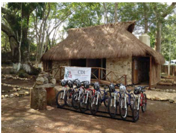
Figura 131.- Ejemplo de sanitarios con vestidores. Proyecto San Mateo, Peto. Foto: Mario Sánchez.
