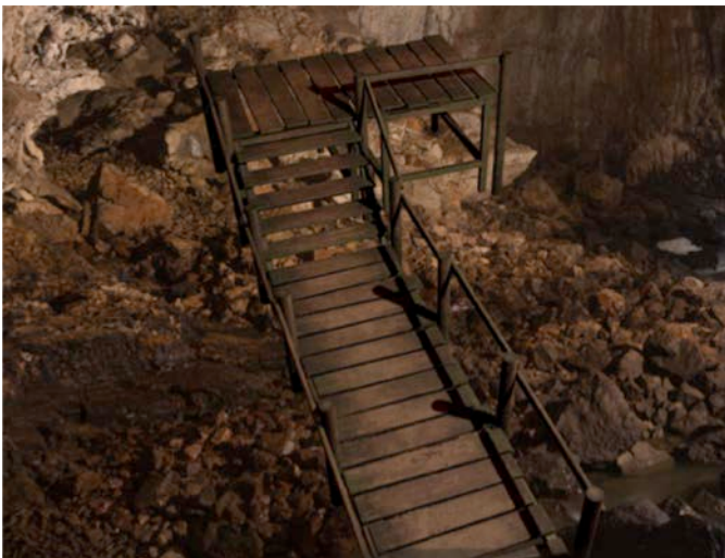
Figura 137.- Ejemplo de cómo adecuar el andador de madera a la irregularidad de la roca madre. Ilustración: Carlos Duarte. Figura 138.- Detalle de la instalación del andador. Dibujo: Joany García.
