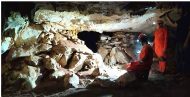
Figura 41 .-Lado posterior del muro, la base de la construcción de bloques de piedra sobre los cuales se acomodaron piedras pequeñas. Foto: Fátima Tec.
