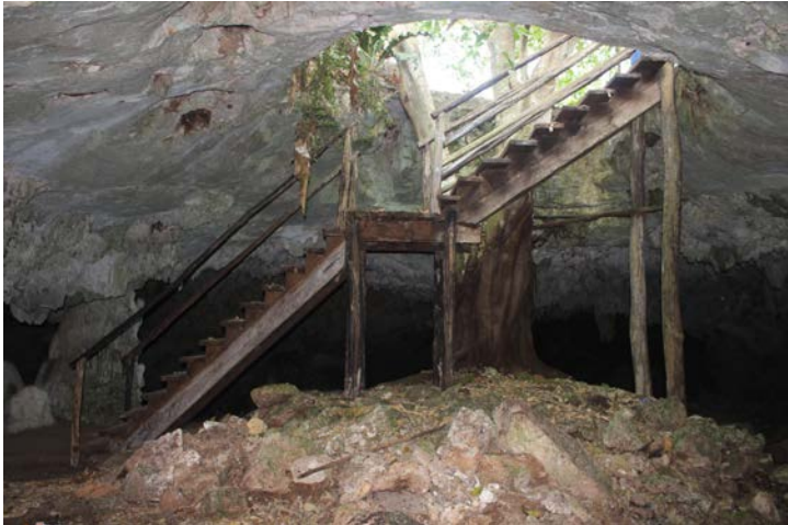
Figura 54.- Perfil de la escalinata de madera cuyos postes están sobre el montículo de piedras (monte de debris) Foto: Natalia Quintanilla. Figura 55.- Vista frontal de la escalinata. Foto, María Gómez.
