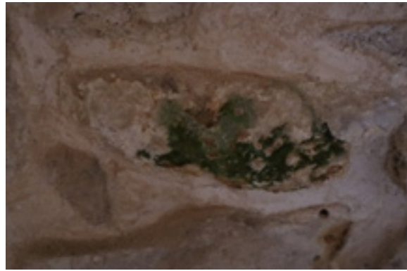
Figura 61: Microorganismos tipo algas en el interior del cuarto 1 (JMS).
