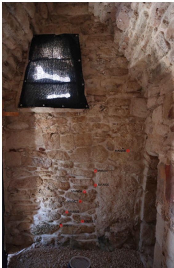
Figura 76; Localización eflorescencias del muro oeste analizadas con Florescencia de Rayos X (JMS).
