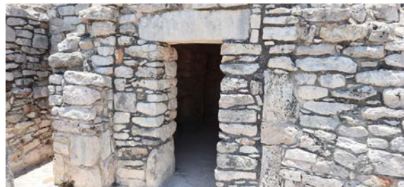
Figura 52: Dintel y jamba del Templo de los Nichos Pintados (JMS).
