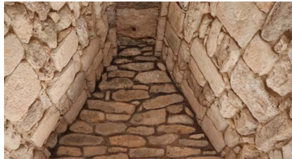
Figura 51: Piedras estilo Puuc y piedras burdas de la bóveda del Cuarto 4 del Templo de los Nichos Pintados (JMS).
