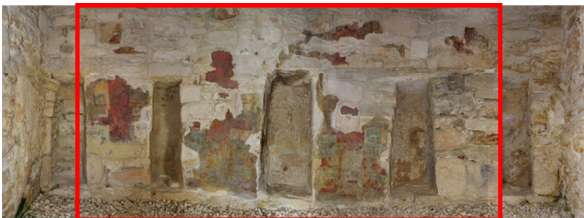
Figura 124: Reenterramiento y colocación de la réplica.
