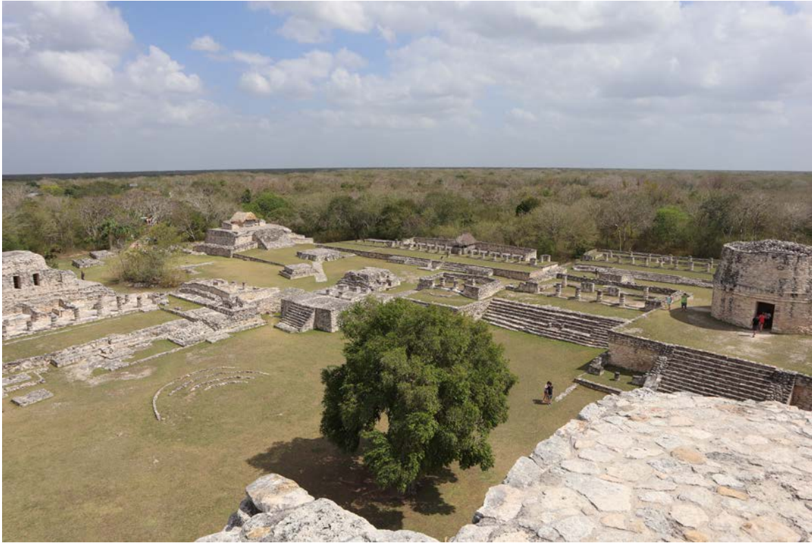
Figura 15: Reducido nivel de lectura de las estructuras que forman el centro monumental de Mayapán (JMS).
