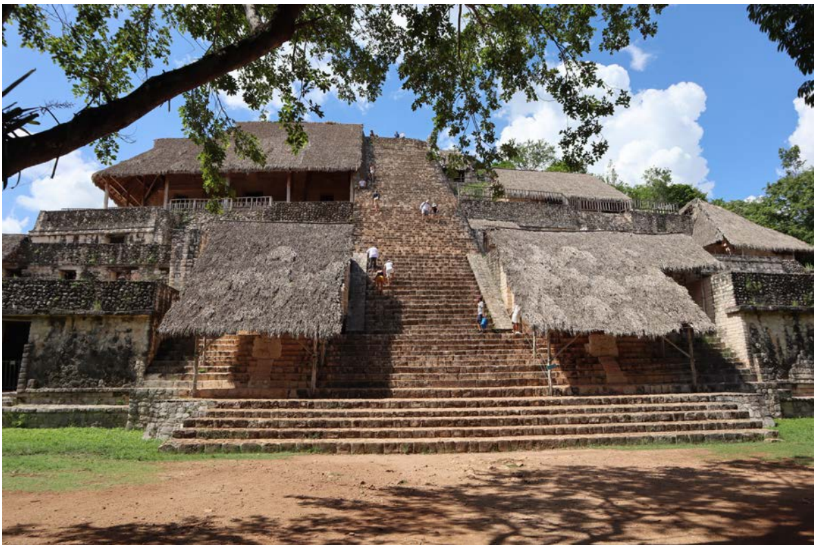
Figura 12: Elementos de protección de los estucos en Ek Balam (JMS).
