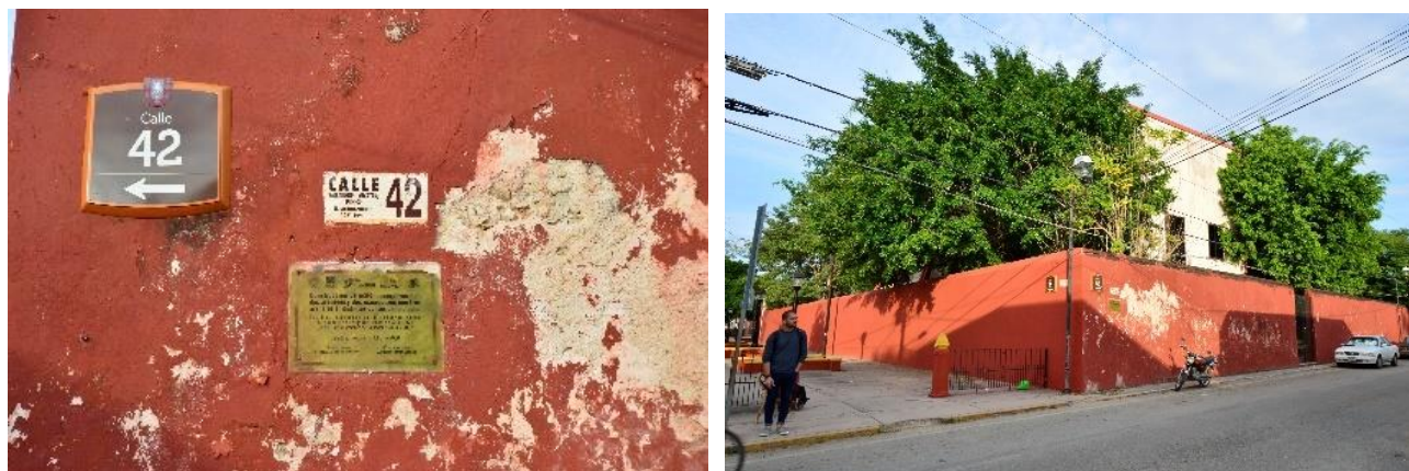
Figura 73: Muro perimetral del conjunto. Foto: Alejandro Leal.
