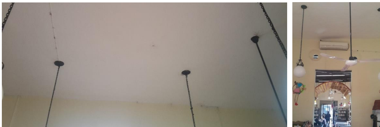
Figura 94: Techos actuales de la biblioteca. Sustitución de la cubierta de rollizos por, cubierta de Hormigón. Foto: Autora.
