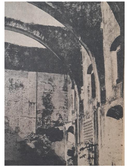
Figura 2: Pérdida del entrepiso y la cubierta del inmueble del Telar. Fuente: Periódico, Por Esto 25 de septiembre de 1977.
