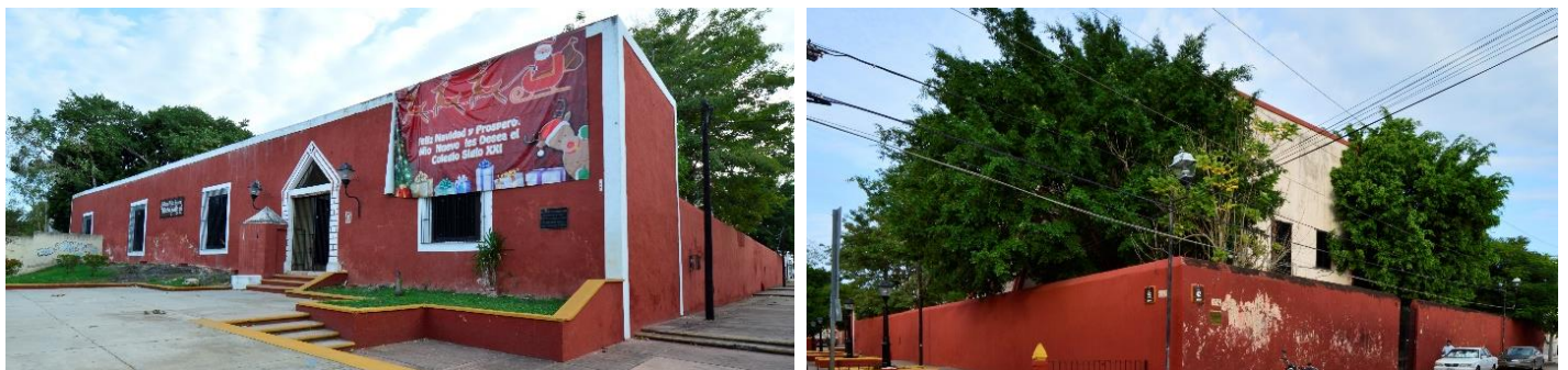
Figura 31: 1_Acceso por el Oriente 2_Acceso por el Poniente Fuente: autora
