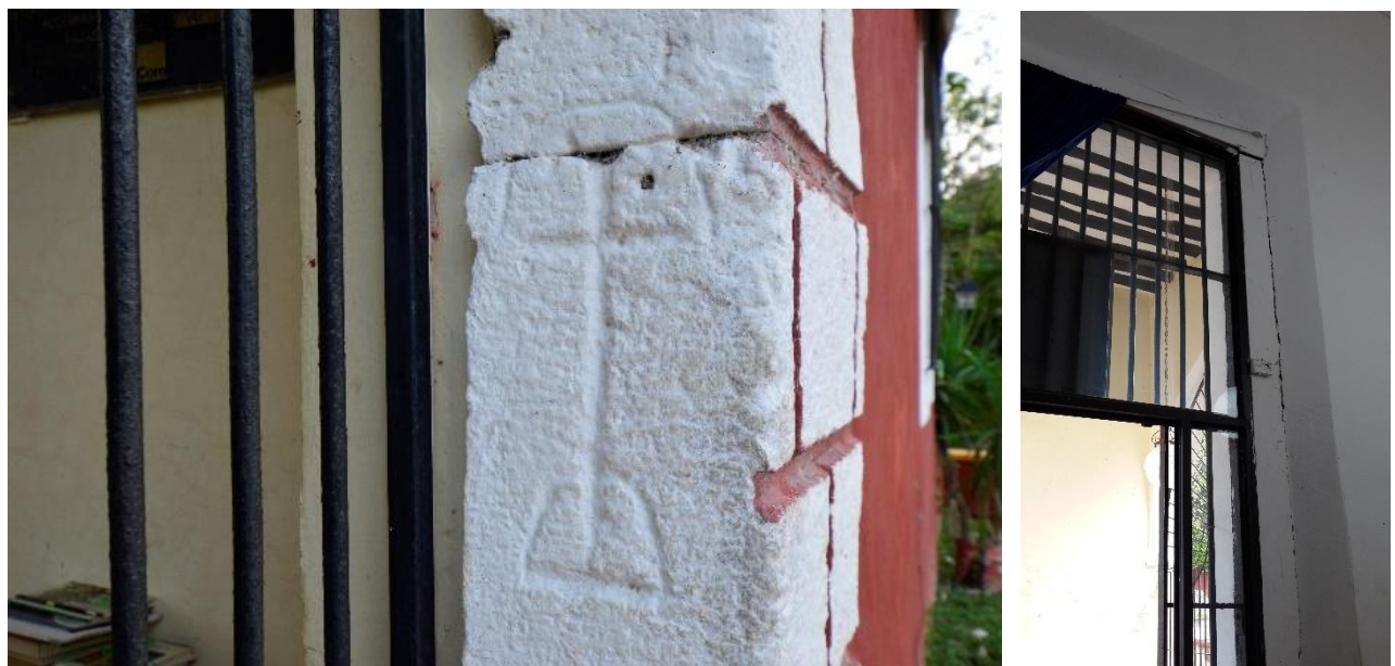
Figura 75: Muros interior y exterior en la Biblioteca. Foto: María González.
