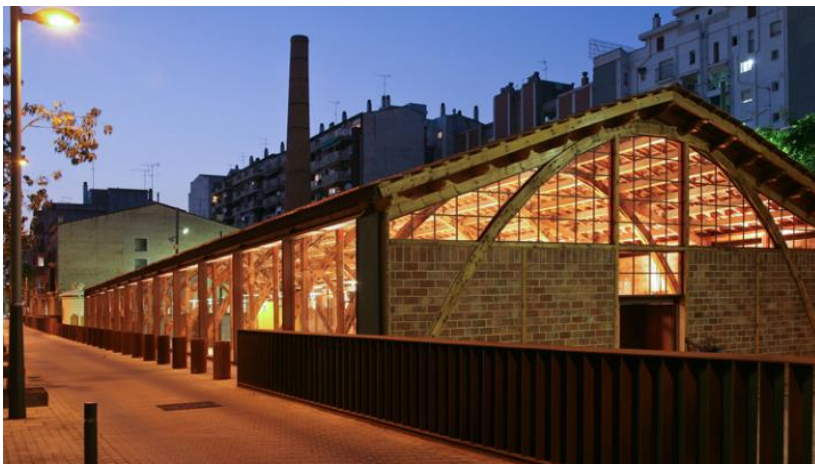
Figura 117: Exterior de la nave.
