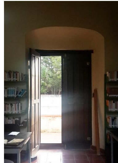
Figura 86: Vano Capialzado, Biblioteca. Foto: Autora.
