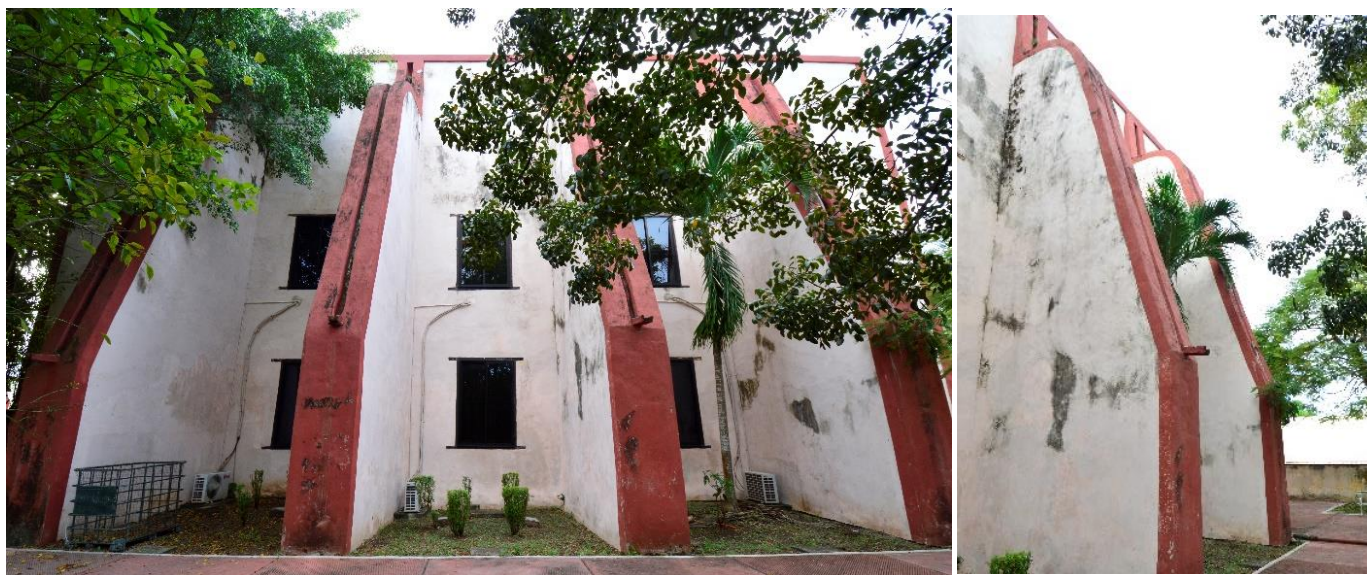
Figura 66: Contrafuertes del Teatro. Fuente: Autor
