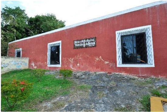
Figura 87: Vanos Abocinado. Foto: Autora.
