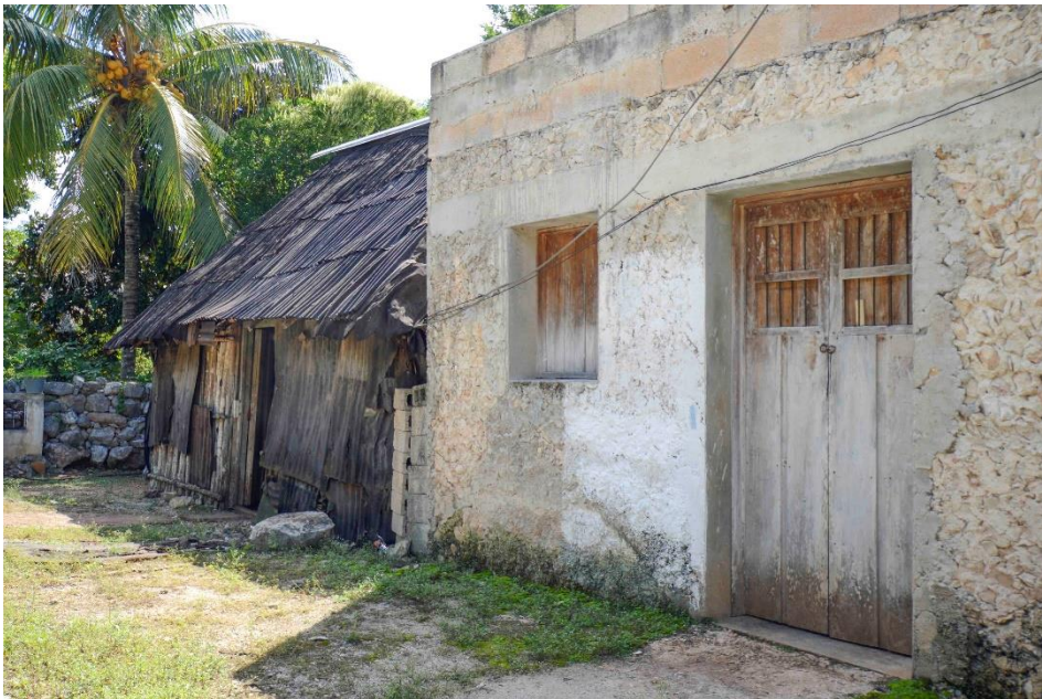
Figura15: Káua. Altos grados en la pérdida de la Arquitectura Vernácula identitaria de la Región. Casas de construcción tradicional, que conviven con las casas de materiales nuevos. Fuente: Autor.
