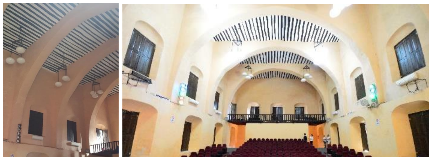
93 Figura 67: Arcos Fajón en el interior del Teatro. Fuente: Autor
