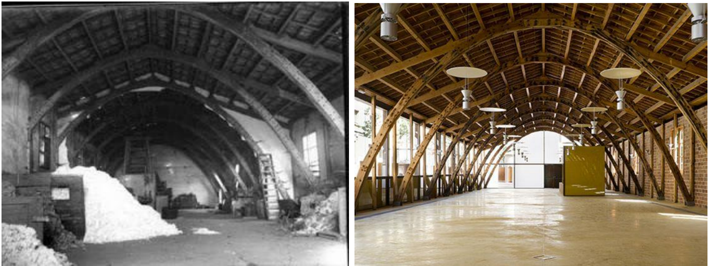
Figura 118: Interior de la nave. Imagen antes y después de la intervención
