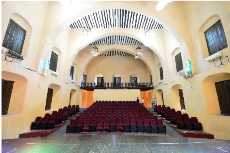
Figura 79: Arcos de medio punto, Arcos Fajón. Foto: Alejandro Leal.
