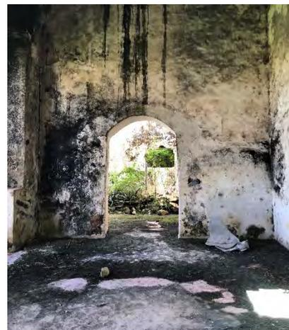
Figura 120 Espacio con pisos y muros con humedad. Fuente: imagen recuperada de la autora, diciembre 2019.
