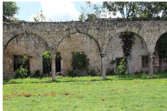
Figura 125 Muros de fachada con pérdida de acabado. Fuente: imagen propia de la autora, marzo 2019.
