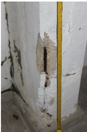
Estallamiento en pilar y exposición de acero de refuerzo
