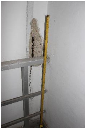
Estallamiento en pilar y exposición de acero de refuerzo
