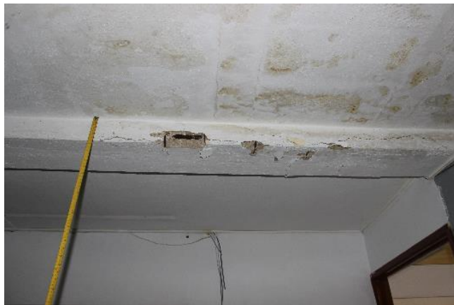
Estallamiento y exposición de acero de refuerzo en trabe
