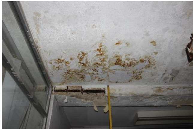
Estallamiento y exposición de acero de refuerzo en trabe
