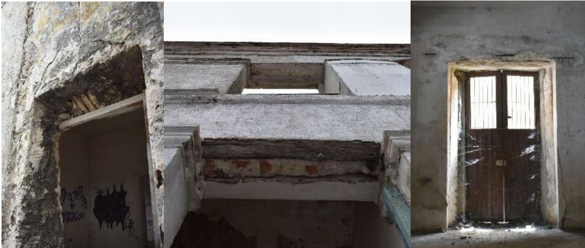
Ilustración 61. Fotografías de los tipos de cerramientos del edificio Xculucya 2017; dintel horizontal con dovelas de piedra, dintel con doble viga de madera y cerramiento de concreto armado. Fuente: Elaboración propia.
