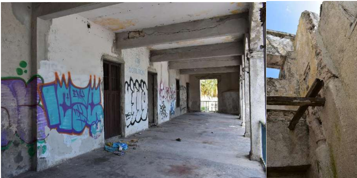
Ilustración 58. fotografía del muro de 60cm (eje 02 entre E y F) y uro de 46 cm (eje A con 02) del edificio Xculucya 2017. Fuente: Elaboración propia.
