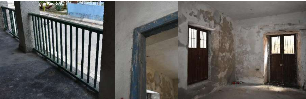
Ilustración 70. Fotografías de los barandales (espacio B2), marcos y chambranas de carpintería original y cancelería nueva metálica (espacio B3) del edificio Xculucya 2017. Fuente: Elaboración propia.
