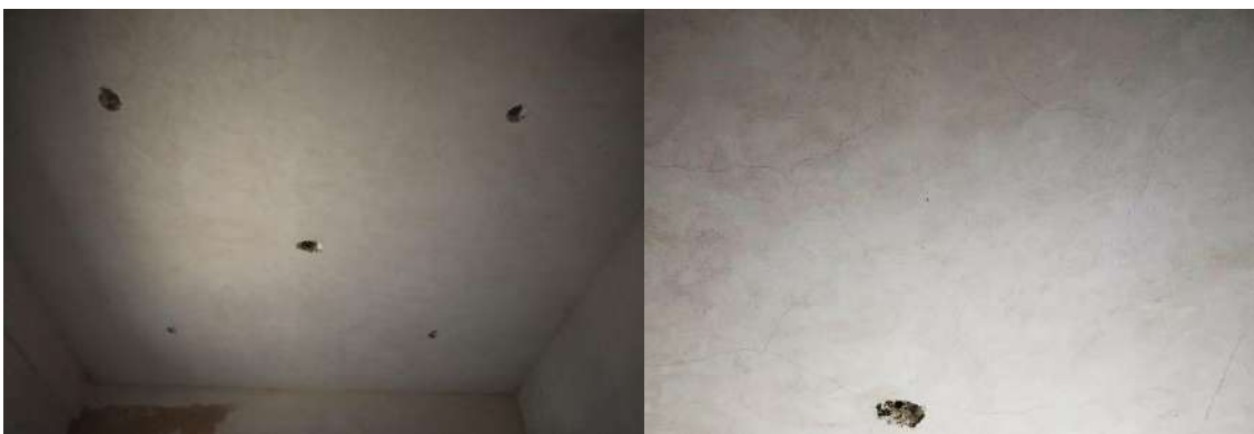
Ilustración 67. Fotografías de losa de azotea (espacio A4) con acabado craquelado del edificio Xculucya 2017. Fuente: Elaboración propia.
