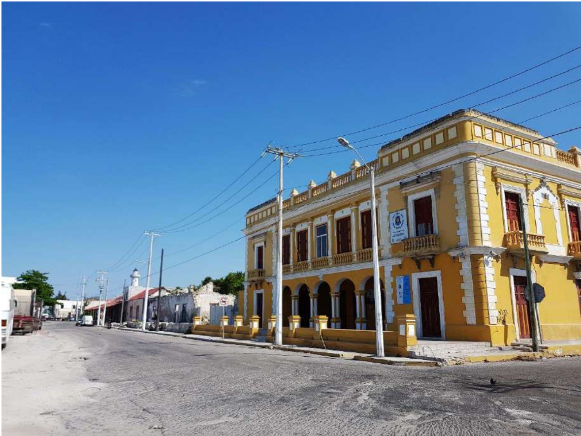
Ilustración 37. Fotografía de la calle 25, el edificio Stella Maris y el faro. Fuente: Elaboración propia.
