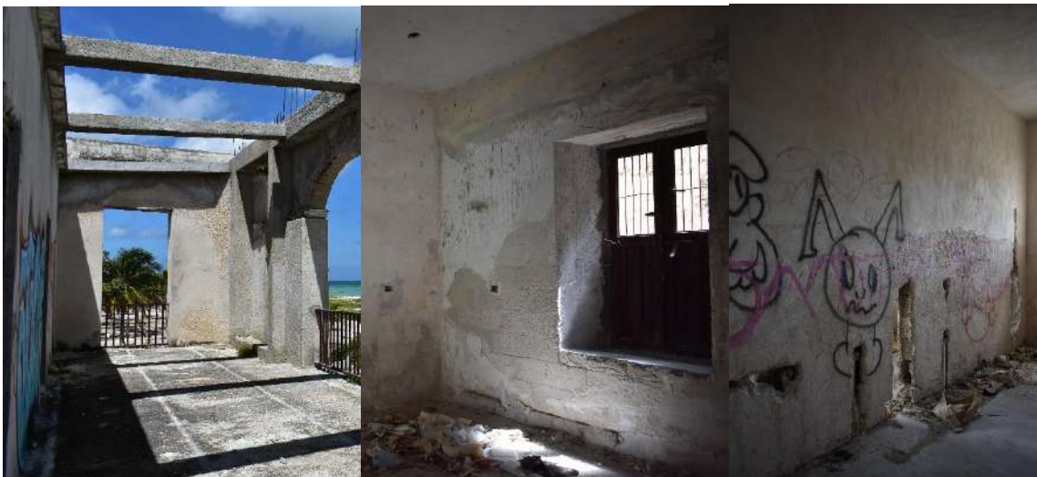
Ilustración 62. Fotografías de las estructuras de concreto (espacio A1) y muros de block (espacio B11) de refuerzo y muros divisorios (espacio A8) para reestructuración de espacios del edificio Xculucya 2017. Fuente: Elaboración propia.
