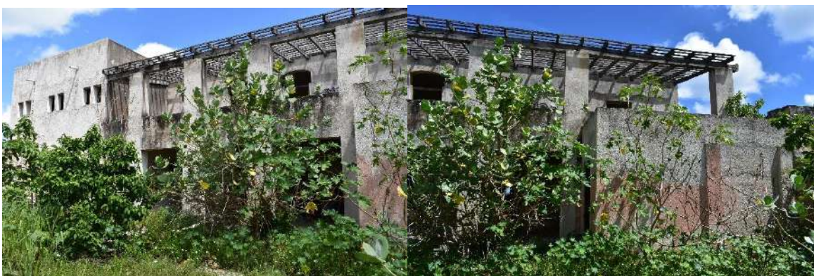
Ilustración 46. Fotografías de la fachada sur del edificio Xculucya 2017. Fuente: Elaboración propia.
