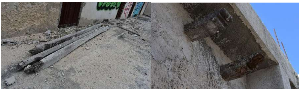
Ilustración 63. Fotografías de vigas de madera originales y canes de madera (espacio A1) del edificio Xculucya 2017. Fuente: Elaboración propia.
