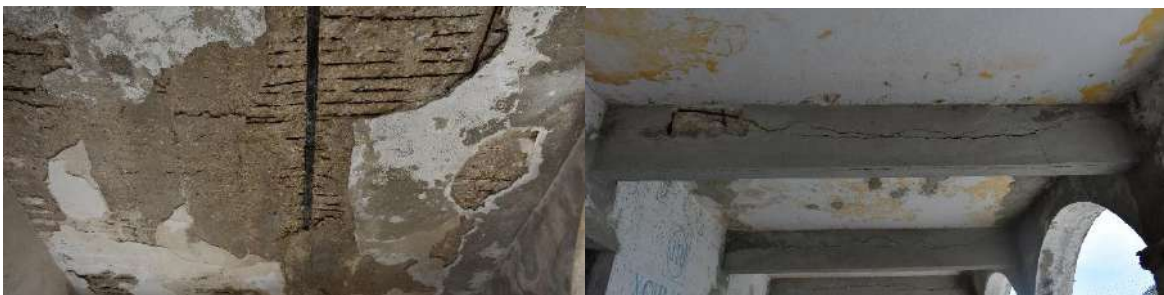
Ilustración 65. Fotografías de entepiso de concreto armado con vigas de caoville (espacio Ba) y de trabes de concreto (espacio B1) del edificio Xculucya 2017. Fuente: Elaboración propia.
