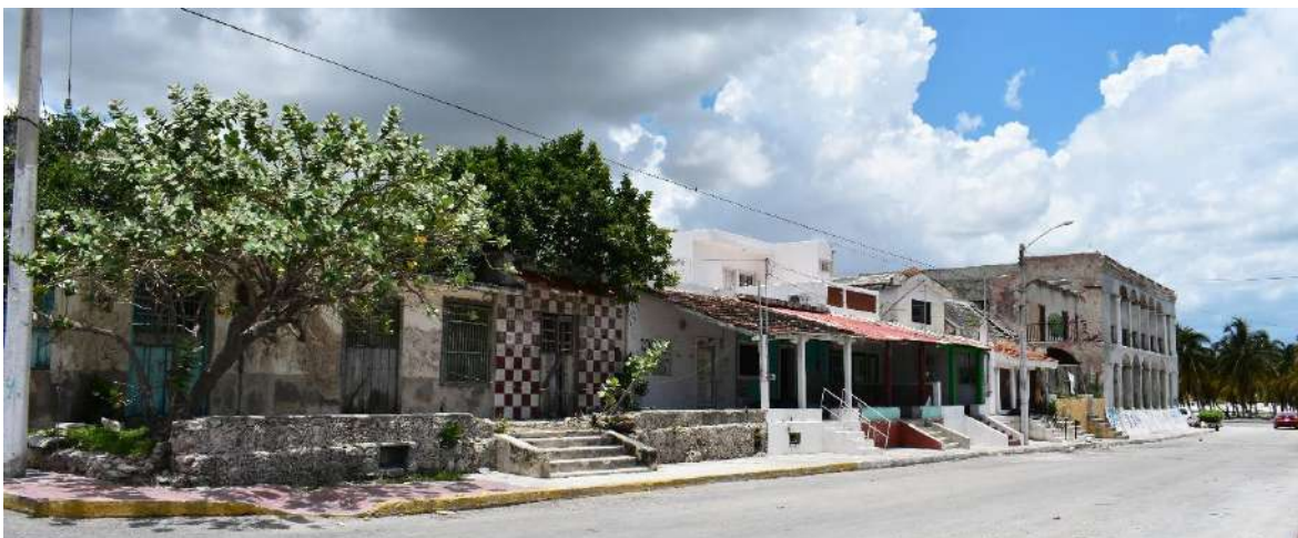
Ilustración 32. Fotografía actual del corredor Xculucya en la calle 25 entre 86 y 88. Fuente: Elaboración propia.
