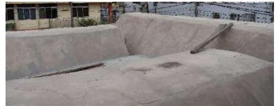
Ilustración 56 Recubrimiento de Cubierta Etapa 1 Fuente: Propia
