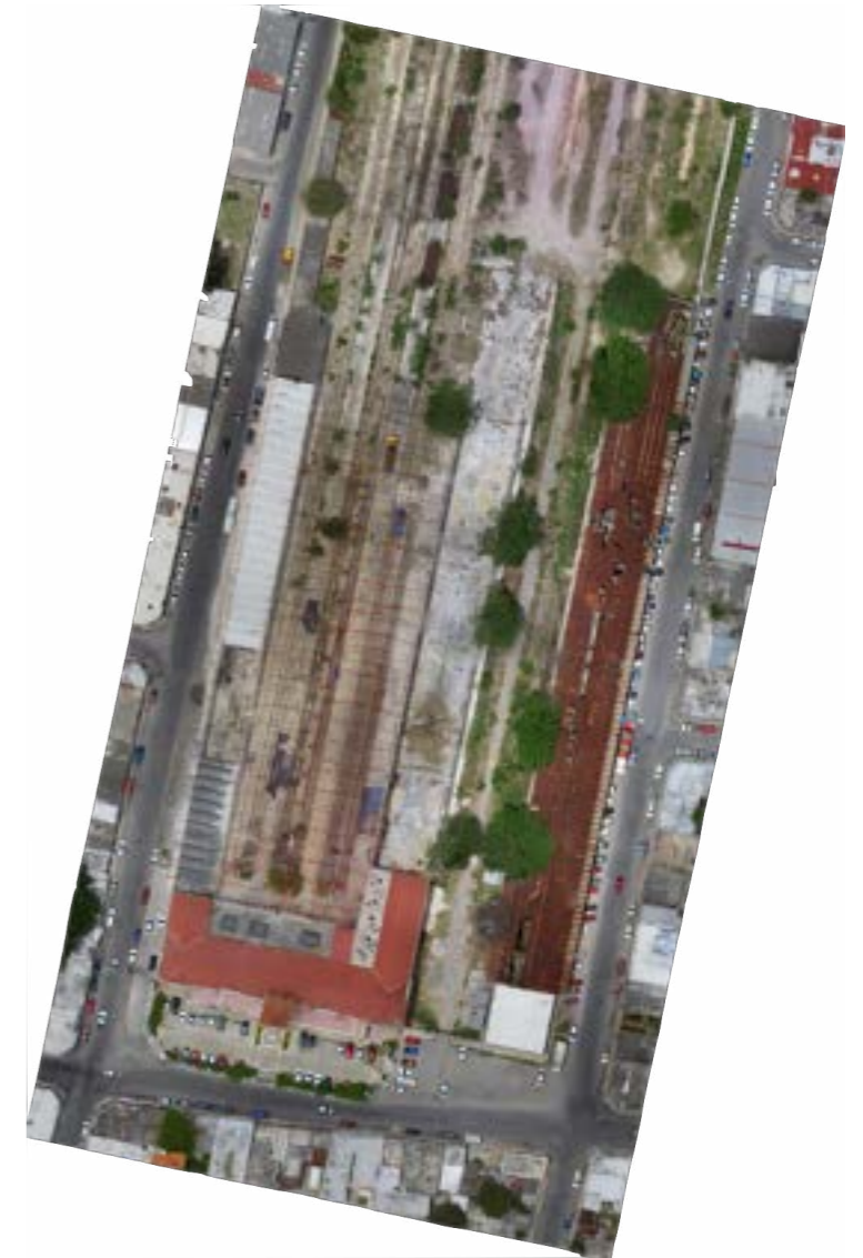
Fotografía aérea del conjunto sur. Venegas, 2018.
