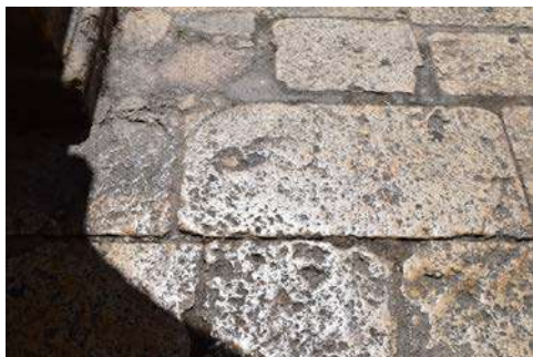
Detalle de burilado en piedras que conforman el corredor sur del claustro.
