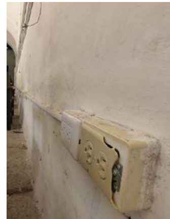
Instalación de enchufes y canaletas en corredor este del claustro.
