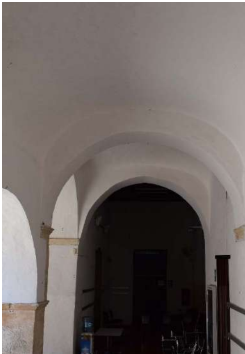
Fig. 5.6 Bóveda de cañón en claustro bajo.
