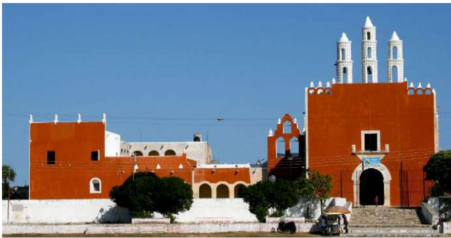
Fig. 1.1 La fotografía superior nos permite observar algunos de los diferentes elementos que constituyen al conjunto conventual de Huhí, Yucatán: Templo, capilla, portal de peregrinos y convento.
