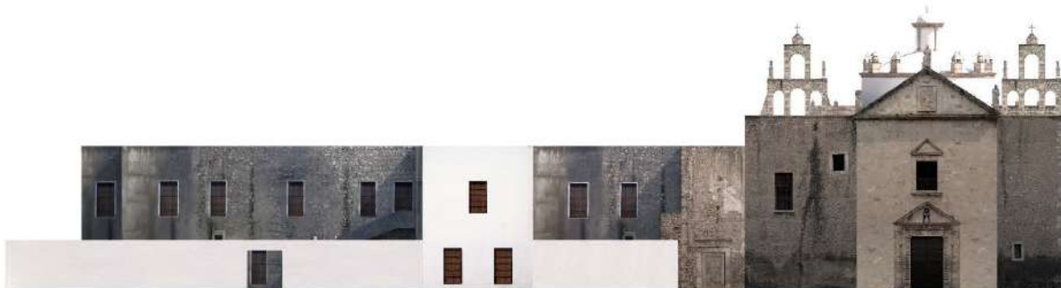
Fig. 0.1 Fisonomía actual de la fachada oeste del Conjunto conventual de la Mejorada.
