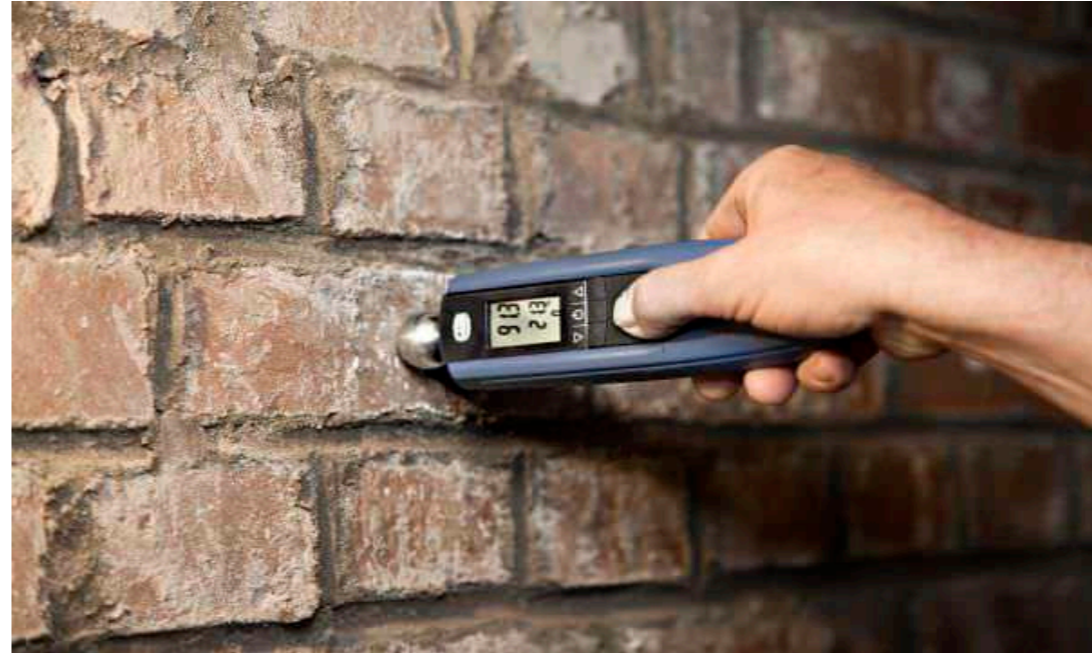
Utilización del humidímetro en muro.
