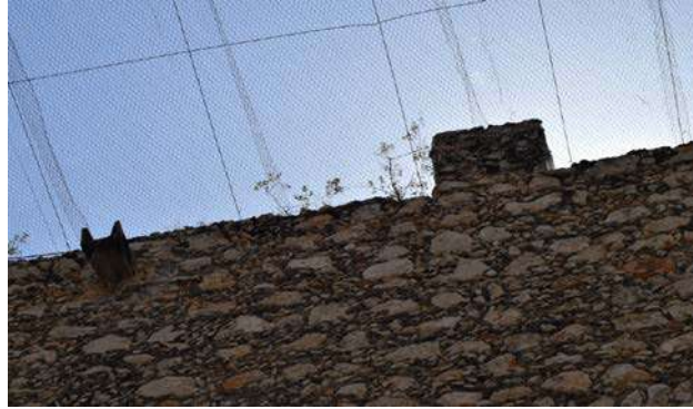
Detalle de pérdida de acabado en la fachada sur del patio claustal.
