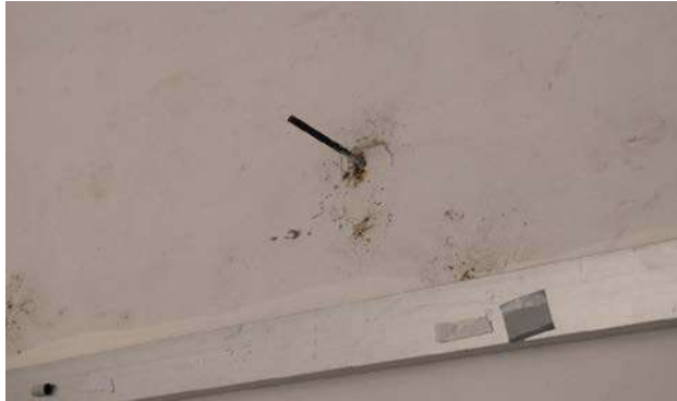
Inserto metálico en muro del corredor sur del claustro.
