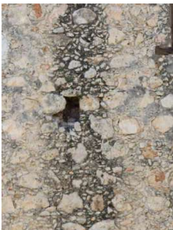
Fig. 5.3 Detalle del muros claustral norte
