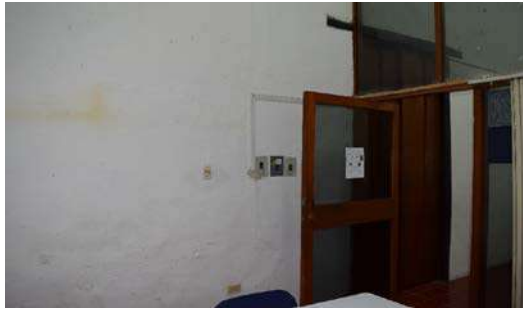
Cancelería divisoria en el corredor oeste del claustro alto.
