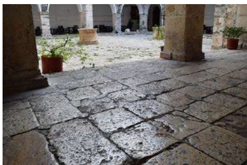
Burilado en piedras que conforman el corredor norte del claustro.
