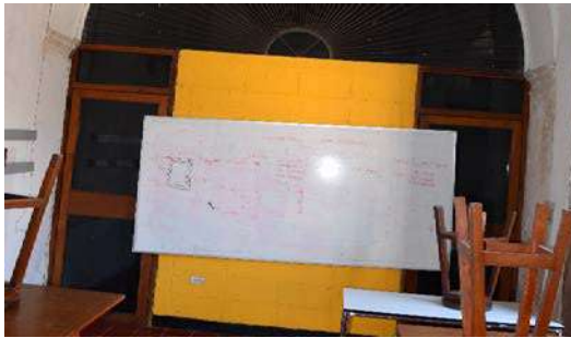
Muro divisorio en corredor sur del claustro alto.
