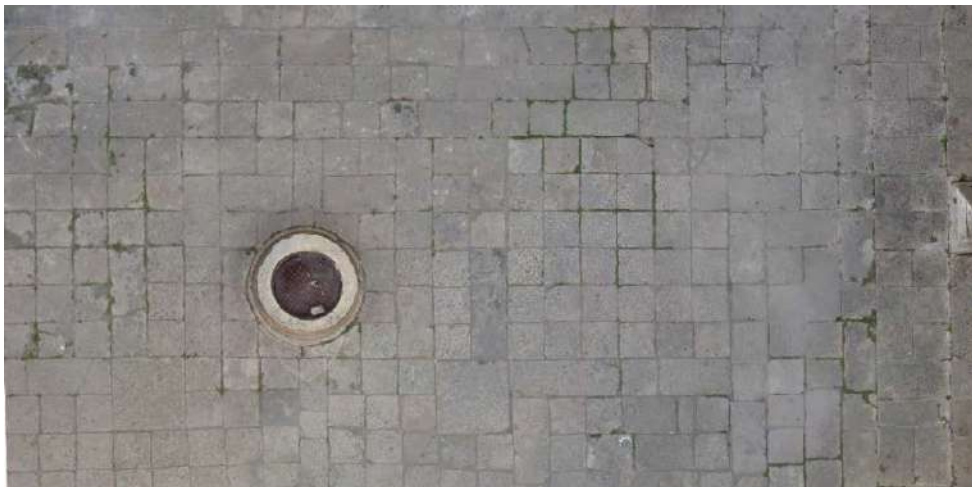
Fig. 5.2 Imagen cenital que muestra los pavimentos pétreos del patio claustreal.
