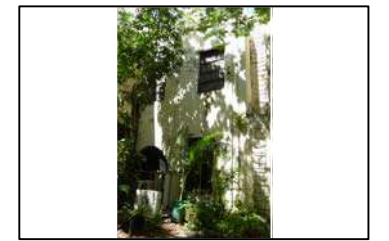
INSTALACIONES INADECUADAS Y ADOSAMIENTO
