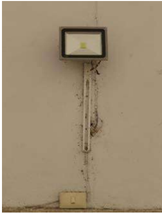
Instalaciones de lámparas en corredor sur del claustro.
