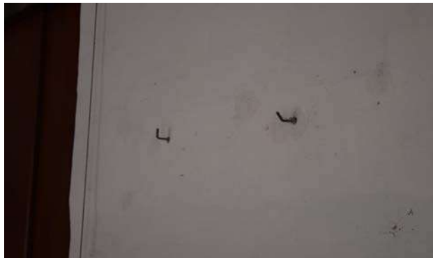
Inserto metálico en muro del claustro alto.
