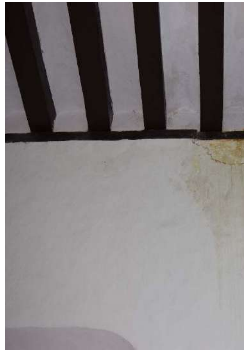
Fig. 5.7 Cubierta de vigas y vigas de arrastre en uno de los corredores del claustro alto.
