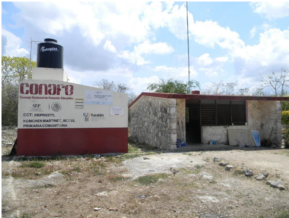
Primaria comunitaria vista exterior de aula y baño.
