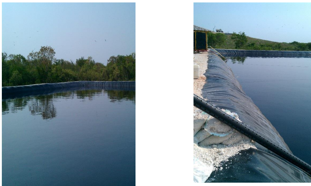
Figura 4.1: Diferentes fotografías del relleno sanitario de la ciudad de Mérida
