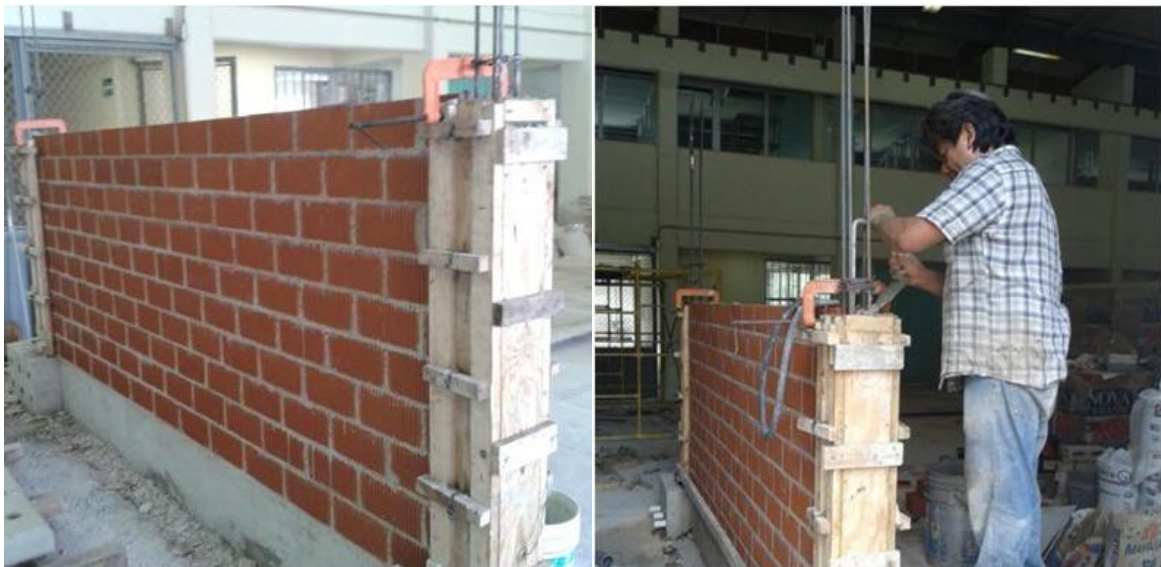
Figura 3.28 Cimbrado y colocación de concreto en castillos.
