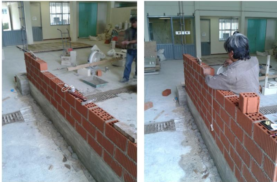
Figura 3.27 Colocación de piezas de mampostería.
