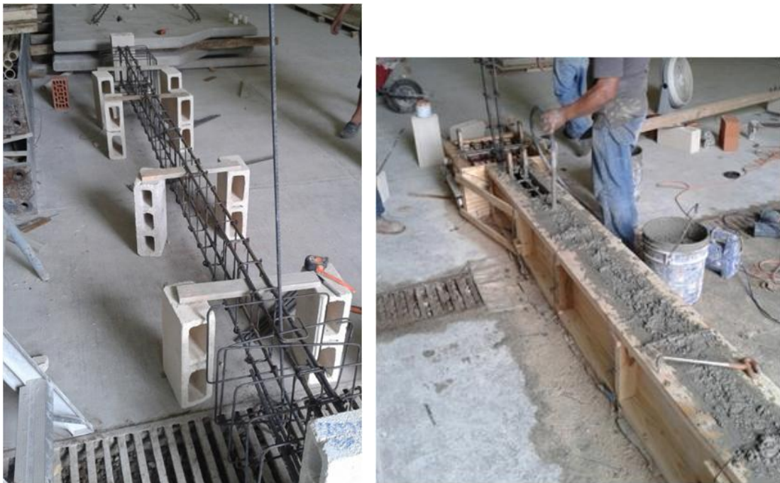
Figura 3.26 Habilitado de acero de refuerzo, cimbrado y colocación de concreto en cadena inferior.
