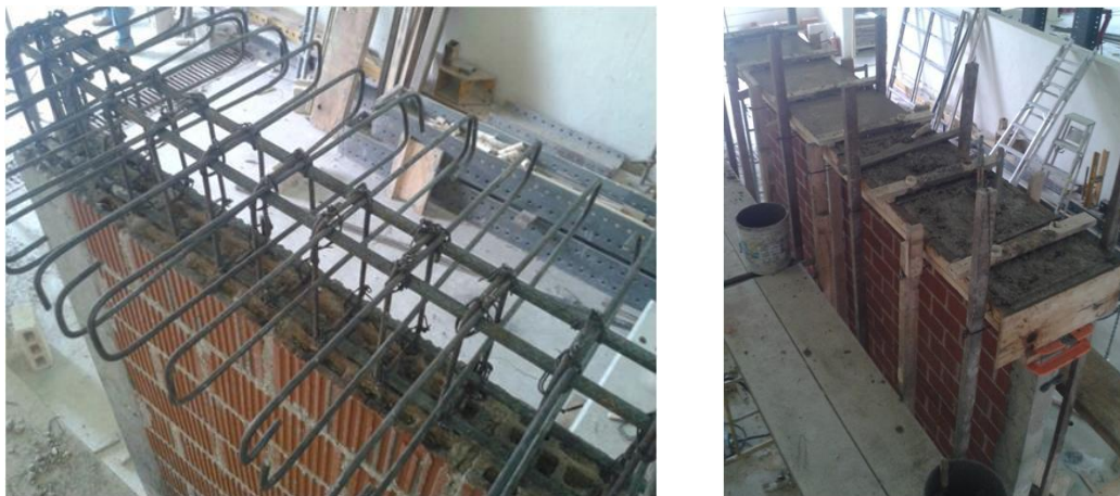
Figura 3.29 Habilitado de acero de refuerzo y colocación de concreto en cadena superior.
