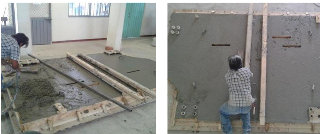
Figura 3.30 Construcción de losa de concreto.
