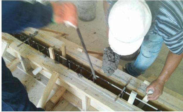
*Figura 3.19 Colocación del concreto de las trabes.*
