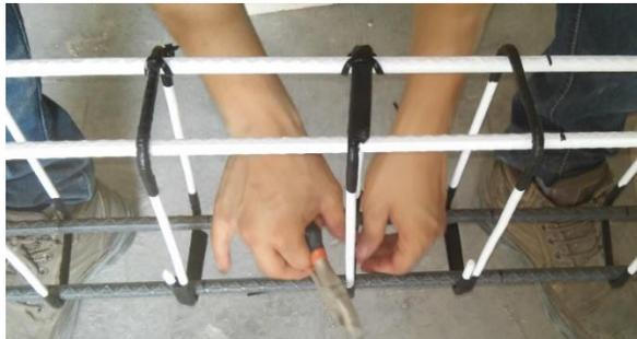
*Figura 3.17 Aislamiento del acero de refuerzo longitudinal del transversal.*
