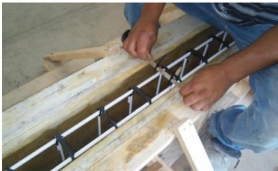
*Figura 3.18 Colocado del armado del acero de refuerzo dentro la cimbra.*
