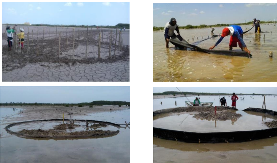
Figura 4. Construcción de Centros de dispersión
