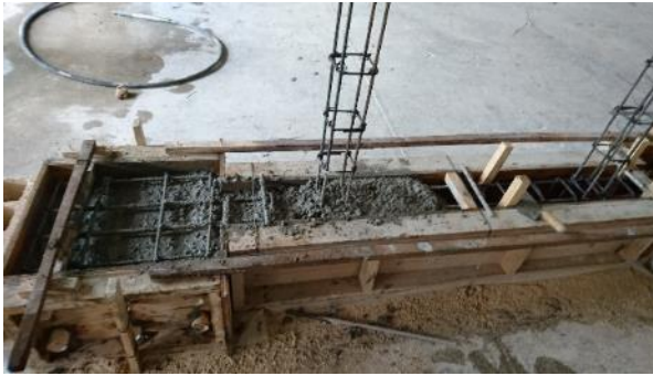
a) Base del muro
