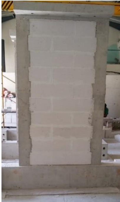
a) Muro Mc3
