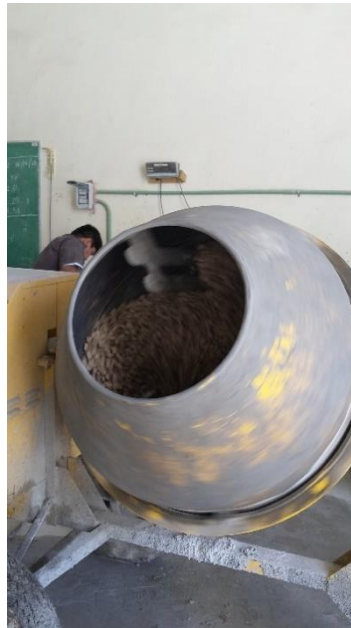
Figura 6.- Mezclado del concreto.
