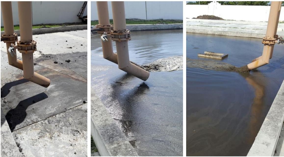
Figura 6.- Cama de secado de lodos (planta de tratamiento de aguas residuales del fraccionamiento “Las Américas”)
