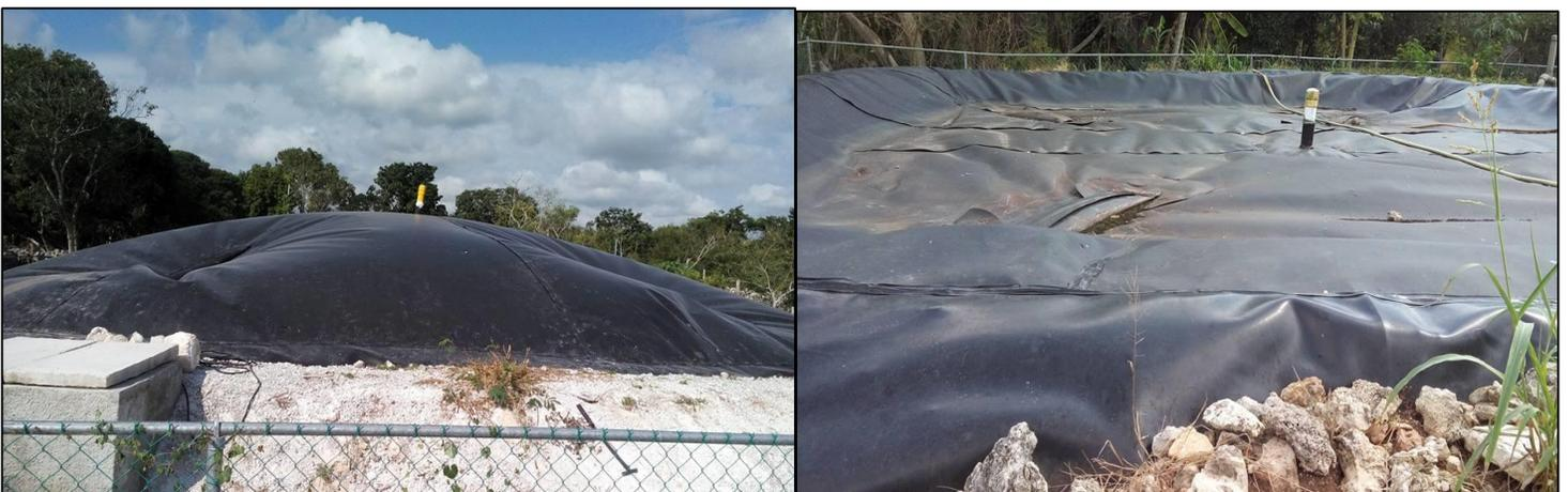
**Figura 5. 1** Diferencia entre la cúpula de los biodigestores
