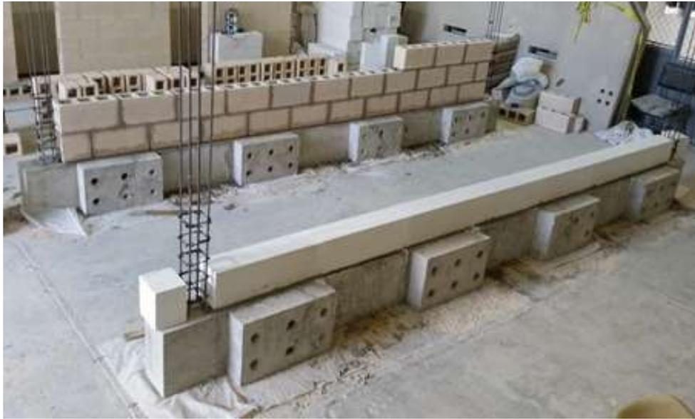
Figura 3.7 Colocación de primeras hiladas
