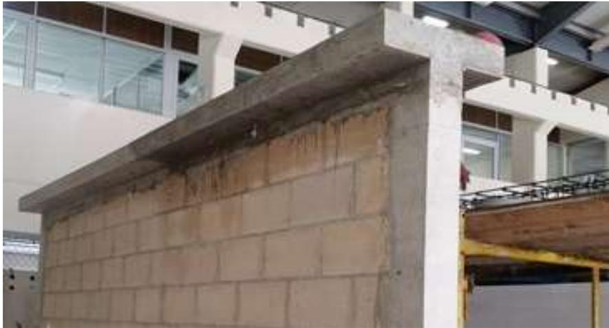
Figura 3.11 Cadena superior del muro
