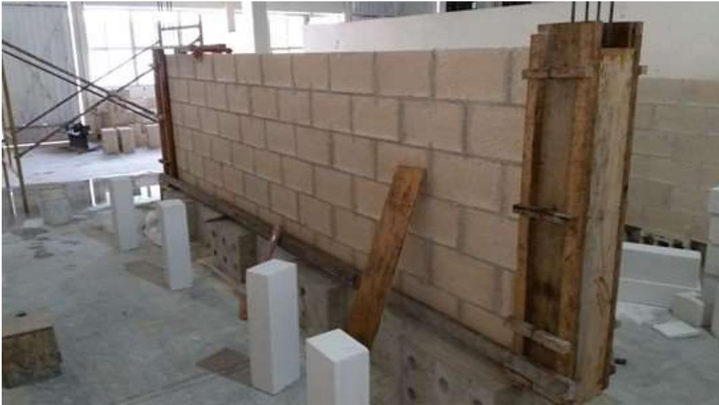
Figura 3.9 Construcción de castillos hasta la mitad de su altura
