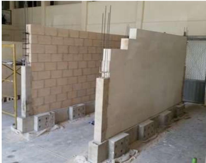
Figura 3.10 Construcción de mitad superior del muro
