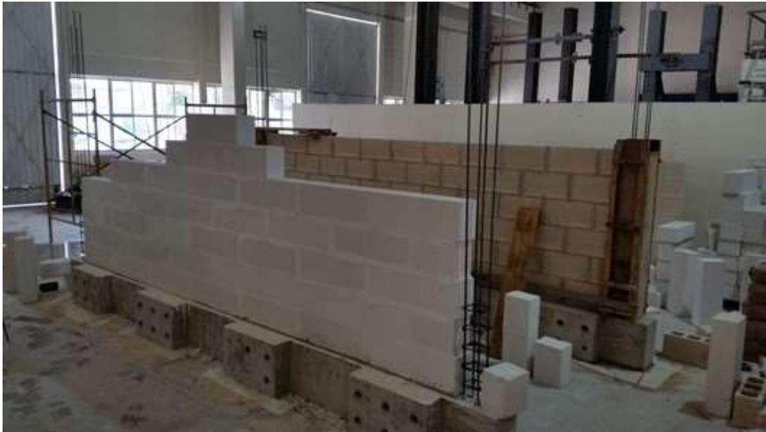
Figura 3.8 Construcción de muros hasta la mitad de su altura
