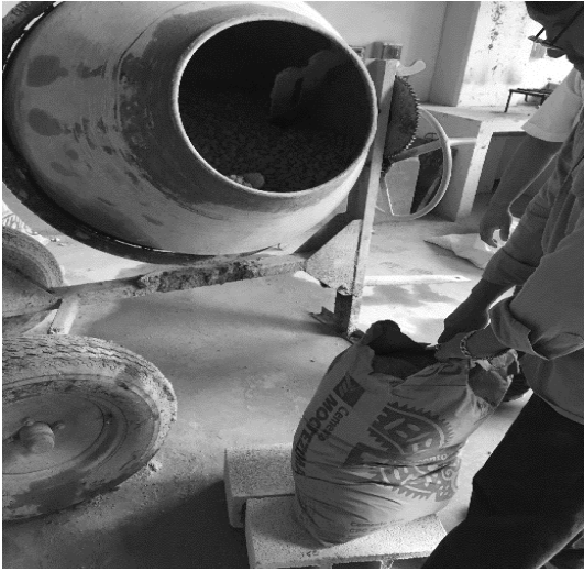
Colocación de materiales dentro de la revolvedora
