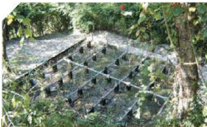
Figura 4 Ejemplo de Estructuras de Distribución en el Afluente para Humedales Verticales (ONU,2008)
