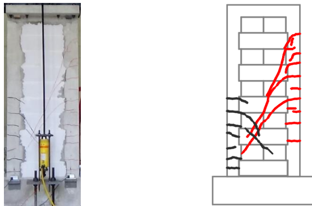
Figura 4.29 Agrietamiento por flexo-cortante y cortante del muro M-2.64-3.0.
