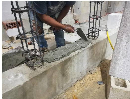
b) Colocación de mortero y primera hilada de CCA.
