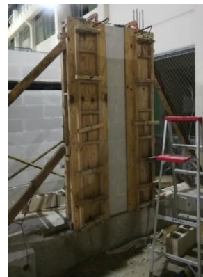
d) Habilitado de cimbra y colocación de concreto de castillos.
