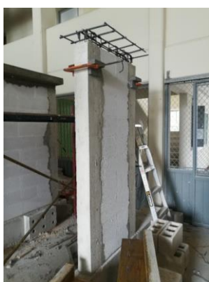
e) Habilitado de acero de cadena superior.
