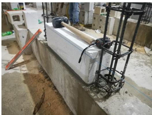
c) Primera hilada reposado por 24 horas.
