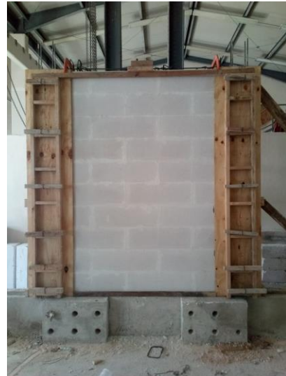
d) Habilitado de cimbra para colocación de concreto
