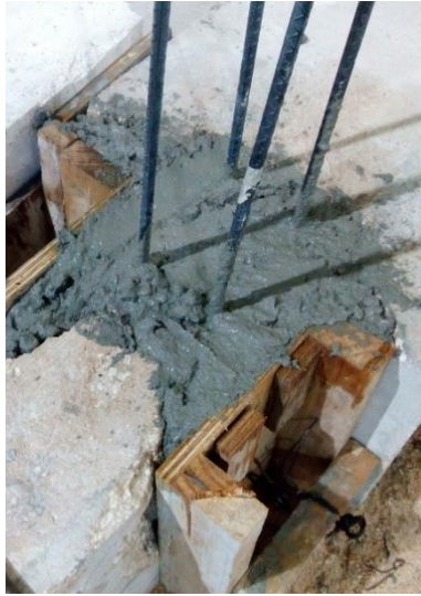
a) Habilitado de acero de refuerzo longitudinal para los castillos
