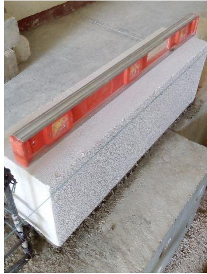
b) Colocación de primera hilada de bloques de CCA
