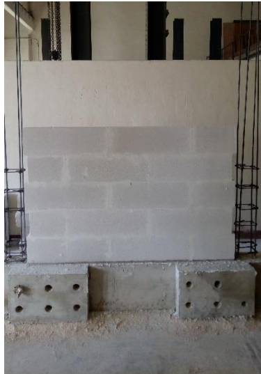
c) Colocación de hiladas posteriores de bloques de CCA
