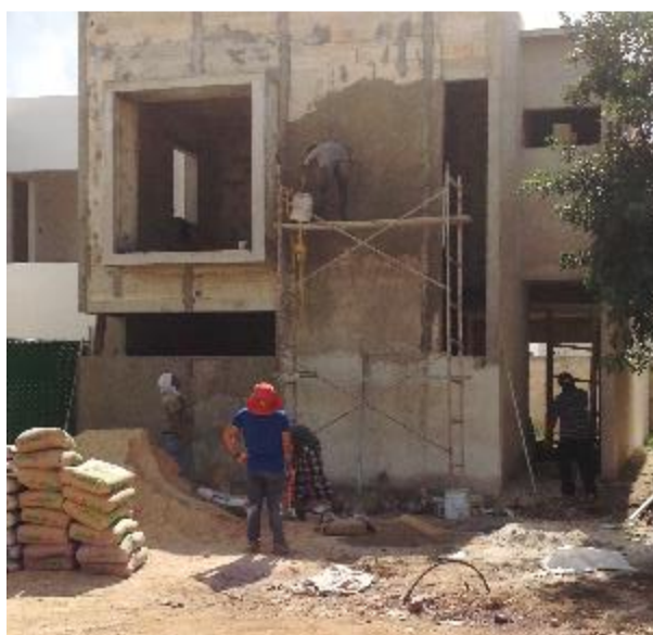
Figura 13. Personal laborando sin uso del equipo de protección personal
