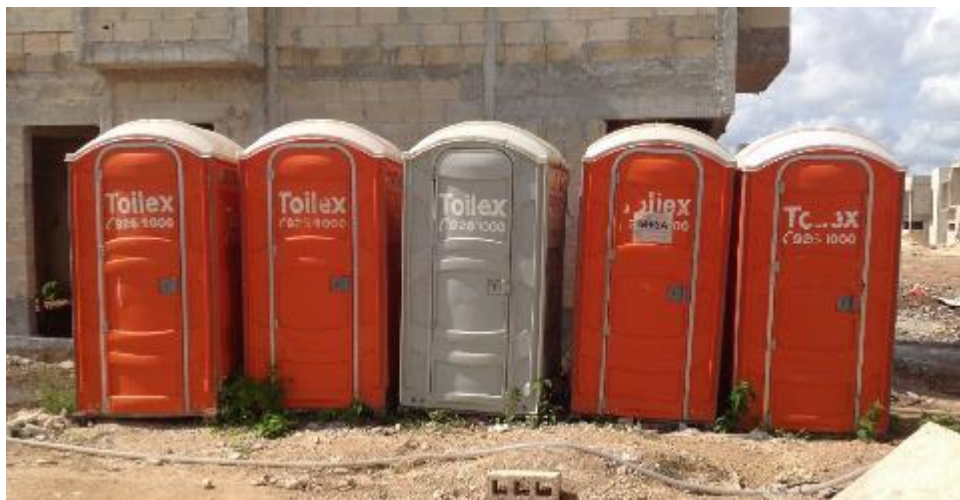
Figura 10. Sanitarios portátiles en sitio de construcción
