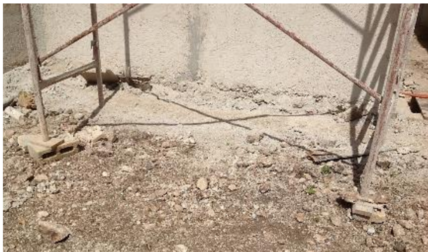
Figura 14. Andamios colocados en superficies inestables
