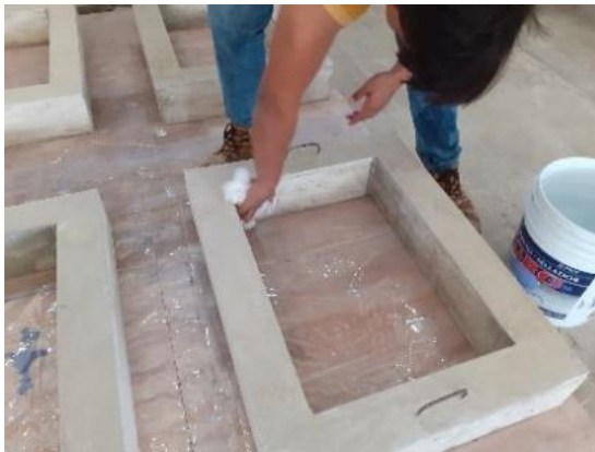
a) Limpieza de marcos de concreto.
