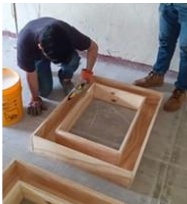
a) Habilitado de cimbra
