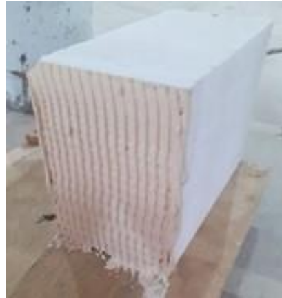
b) Colocación del mortero.
