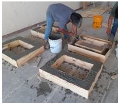
b) Vertido del concreto
