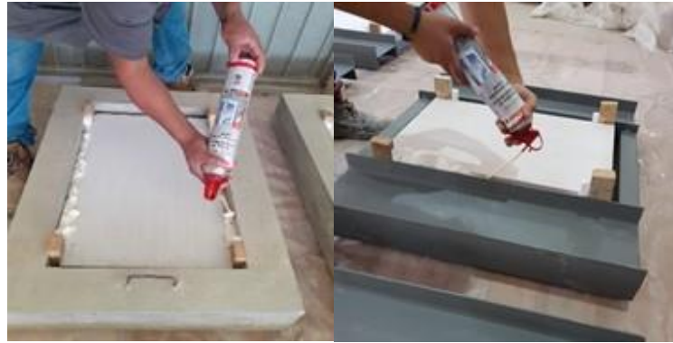
d) Colocación del poliuretano.
