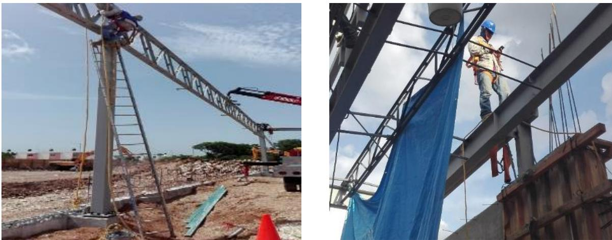
Figura 3.- Obrero intentando descender de una escalera mal colocada y que no cumple con lo requerido para un trabajo en altura, y obrero utilizando su celular mientras está en las alturas.
