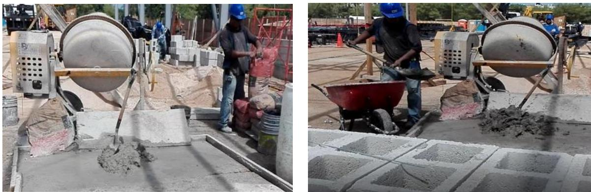
Figura 4.- Obrero expuesto al contacto con el cemento por no usar guantes y tener los brazos al descubierto.
