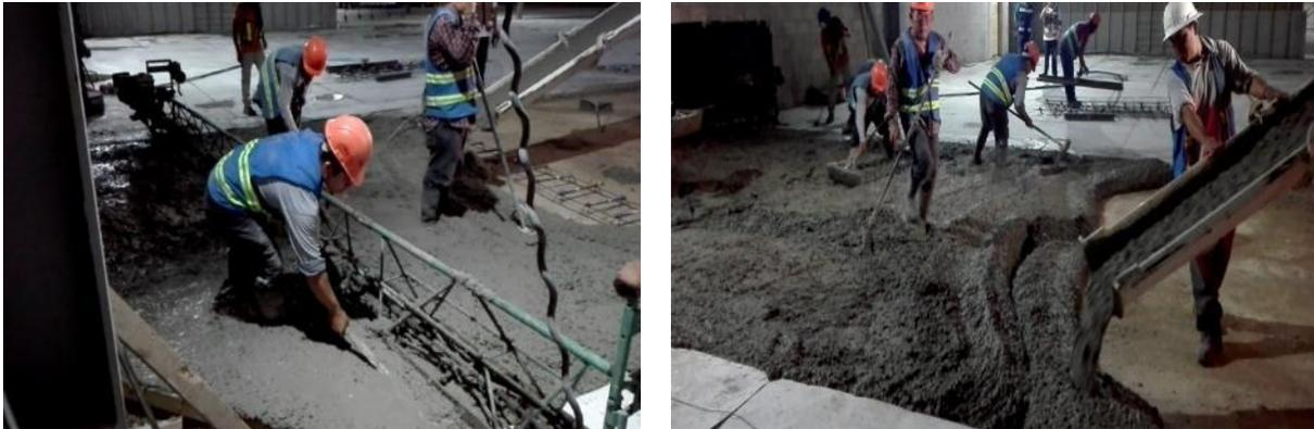
Figura 5.- Obreros expuestos al contacto de concreto con fibra de polipropileno por no usar guantes y tener los brazos al descubierto.
