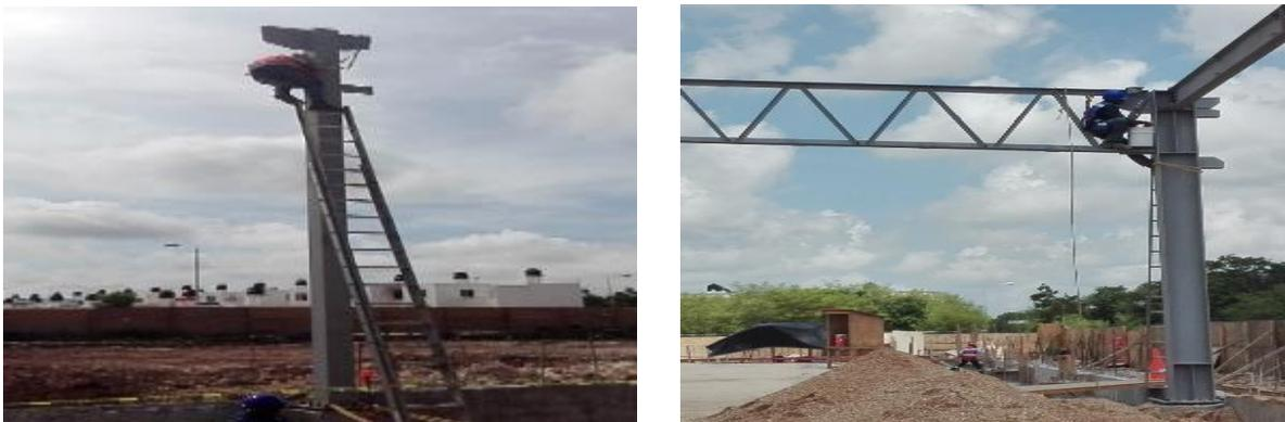
Figura 6.- Posturas forzadas observadas directamente en obra durante el montaje de la estructura metálica.
