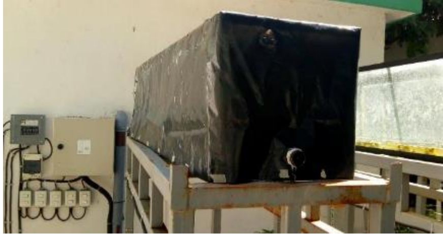
Figura 4. Colocación de plástico negro para evitar la formación de algas dentro de los humedales.
