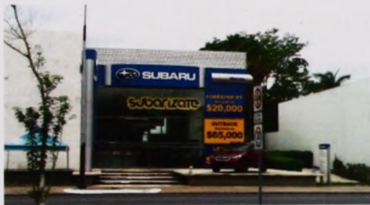
FIGURA 85. Señalización comercial de vinil adosada a vidriera. Subaru: Entre calle 13 y Cto. Colonias, Prol. Paseo de Montejo. Fuente: Talía Román V.
