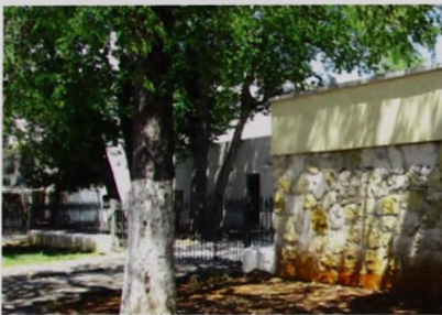
FIGURA 67. Casa habitación de Paseo de Montejo. Muestra un ejemplo de las pocas residencias con uso original. Esquina con calle 35 Paseo de Montejo. Fuente: Talía Román V.
