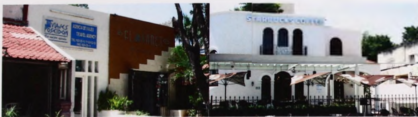
FIGURA 75. Afectación, tanto negativa como positiva del objeto arquitectónico a causa de la señalización comercial Fuente: Talía Román V.
