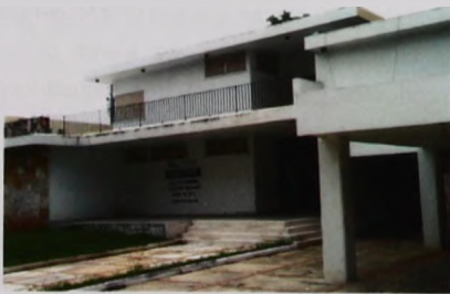
FIGURA 90. Uso de suelo habitacional. Muestra la tendencia de vender o rentar para comercio. Entre calle 11 y 13, Prol. Paseo de Montejo. Fuente: Talía Román V.
