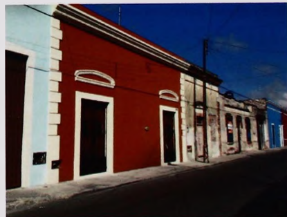
Imagen 36. Fachadas intervenidas y no intervenidas, calle 66.
