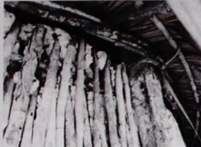
Cerramiento curvo en muro de bajareque 2-4 cm de diámetro.
