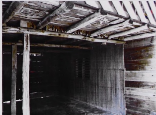
Imagen 4.48. Vigas de madera en entrepiso en vivienda caribeña. Chunhuhub, Quintana Roo, México.
