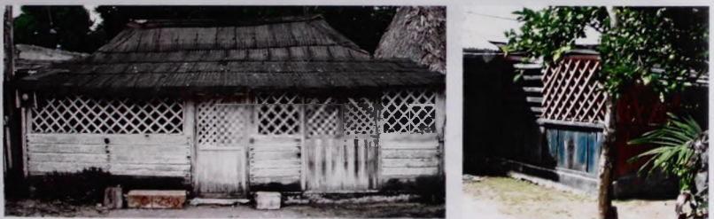
Imagen 3.33. Celosías de madera en fachadas principales de la vivienda caribeña.
