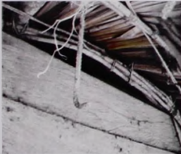
Cerramiento curvo en muro de tabloncillos de madera.
