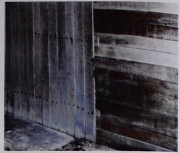
Imagen 4.13. Muros de aparejo combinado. Ubicación: Chunhuhub, Q. Roo, México Fuente: Imagen propia.
