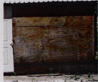
Muro de panel de madera, Ramonal, Quintana Roo, México.
