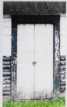
Cerramiento de madera en puertas
