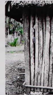
Imagen 4.34 Polines de madera en muros de bajareque, Quintana Roo, México. Fuente: Imágenes propias.
