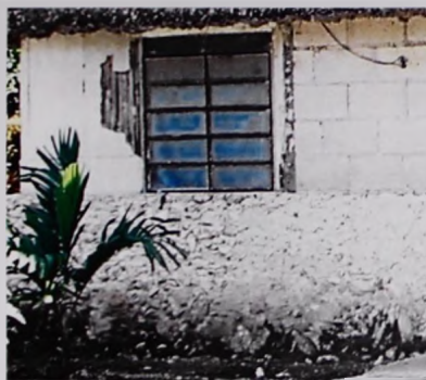
Imagen 4.30 Muro mixtos: bajareque, mampostería y block.
