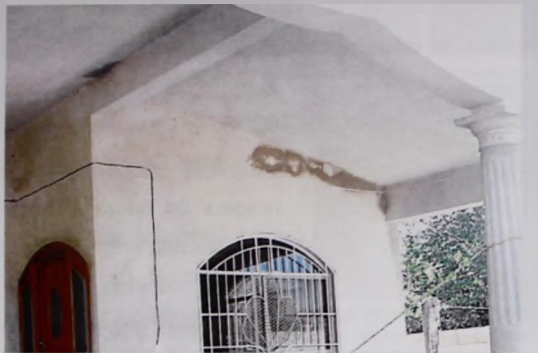
Imagen 4.49. Trabes de concreto armado en vivienda popular. Gavilanes, Quintana Roo, México. Fuente: Imagen propia.
