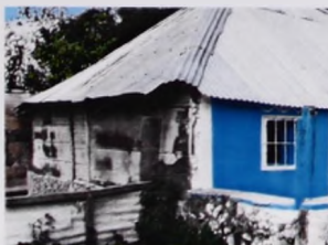
Muros mixtos: rodapié de mampostería y tablonces de madera con aparejo horizontal; planta rectangular. Ubicación: Los Divorciados
