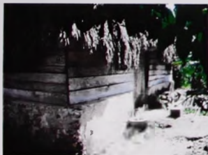
Muros mixtos: rodapié de mampostería y tablonces de madera con aparejo horizontal; planta rectangular. Ubicación: Gavilanes.
