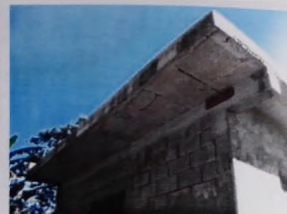
Cerramiento en vivienda popular rural. Fuente: Imagen propia
