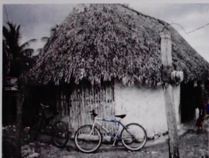
Imagen 4.3. Vivienda con muros de bajareque de 2-4 cm de diámetro con recubrimiento de cal en la fachada principal.
