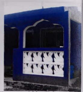
Imagen 4.36. Columnas de concreto armado con elementos adosados.
