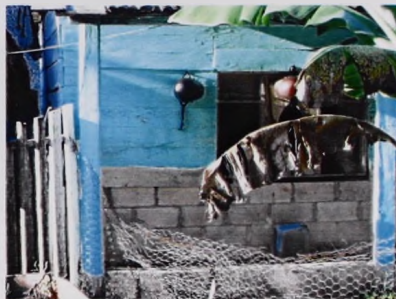
Pozo Pirata. Rodapié de block y tablones de madera en aparejo horizontal.
