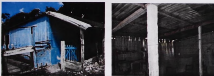
Imagen 4.61 Cubierta inclinada a dos aguas y los apoyos aislados de madera para refuerzo de la estructura de la cubierta. Vallehermoso, Quintana Roo, México.
