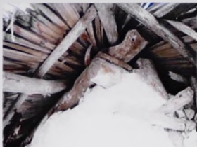
Imagen 4.38 Ensamble del dintel de madera
