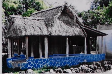
Imagen 4.73. Techumbres intersectadas Ubicación: Chunhuhub, Quintana Roo, México. Fuente: Imagen propia.
