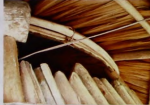
Cerramiento curvo en muro de bajareque 4-10 cm de diámetro.
