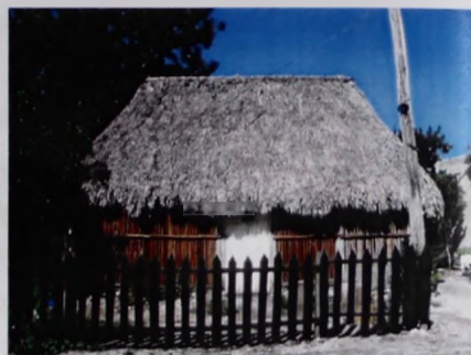
Imagen 4.4. Vivienda con muros de bajareque de 4-10 cm de diámetro con una capa de barniz en la madera.
