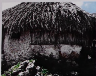
Imagen 4.25. Muros mixtos: Piedra y bajareque de 2-4 cm, Chunhuhub, Quintana Roo, México.
