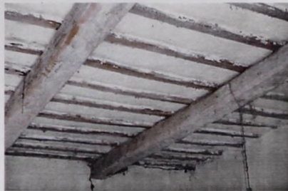
Vigas de madera y rollicillos de madera
