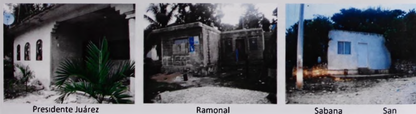
Imagen 4.50. Viviendas rurales con losas planas de concreto armado, Quintana Roo, México.
