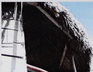
Imagen 4.41. Cerramientos rectos de longitud corta para techos curvos. Ubicación: Chunhuhub, Q. Roo, México. Fuente: Imágenes propias.
