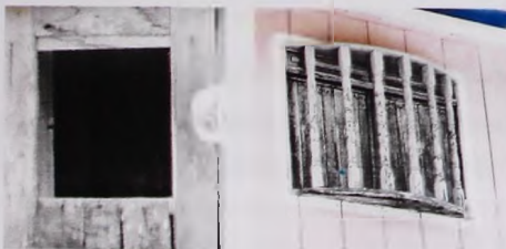
Cerramiento de madera en ventanas
