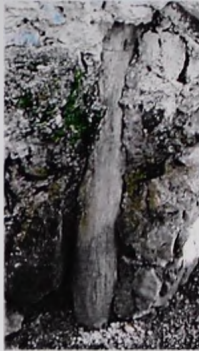
Horcón en muro de piedra.
