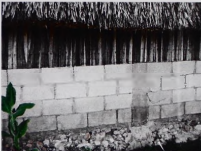
Chunhuhub. Rodapié de block y tablones de madera de 5 cm de ancho en aparejo
