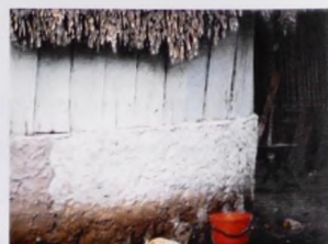
Muros mixtos: rodapié de mampostería y tablonces de madera con aparejo vertical; planta absidal. Ubicación: Pozo Pirata
