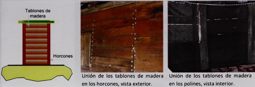
Imagen 4.11. Tablones de madera en aparejo horizontal.
