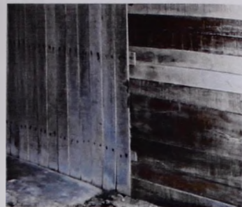
Imagen 4.13. Muros de aparejo combinado. Ubicación: Chunhuhub, Q. Roo, México Fuente: Imagen propia.
