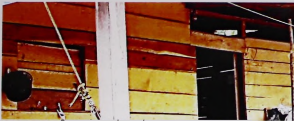
Cerramiento de madera en puertas y ventanas
