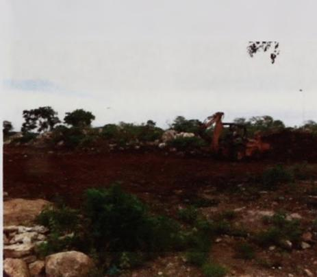
**Figura 13. Limpieza y nivelación del terreno con medios mecánicos.**
