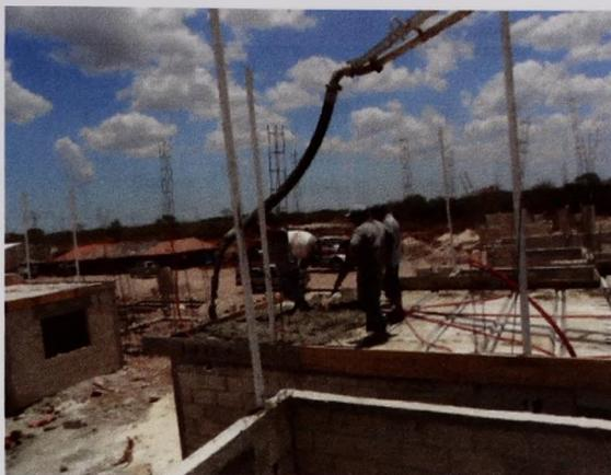
**Figura 26. Inicio de colado de losa de vigeta y bovedilla**
