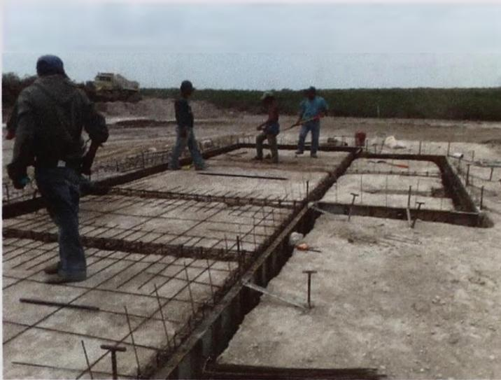
**Figura 30. Armado de zapatas corridas de cimentacion**
