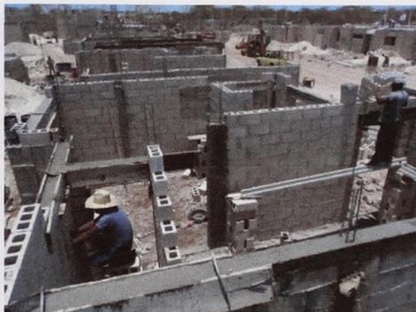
**Figura 21. Muro de mampostería de bloques huecos de concreto vibropresado**
