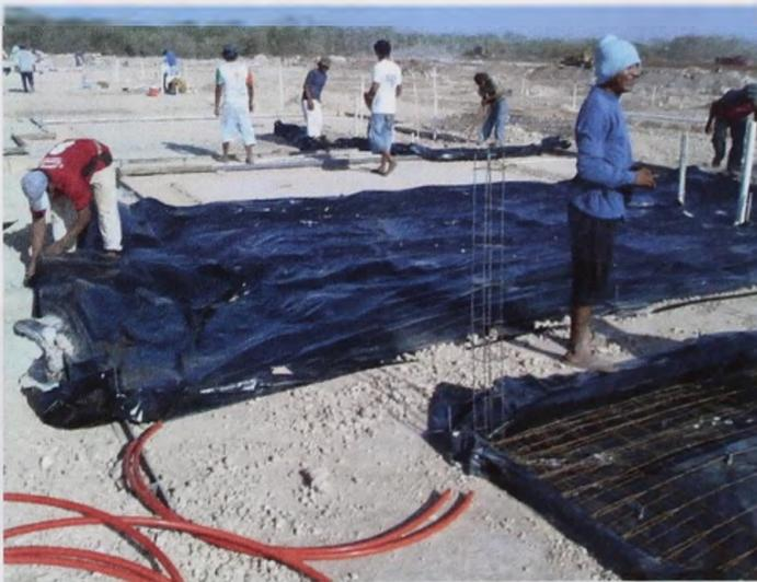
**Figura 31. Preparación del sistema antihumedad de la vivienda**
