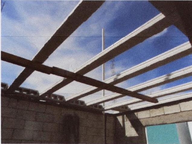
**Figura 24. Cadena de enrase o nivelación, colocación de viguetas, bovedillas y apuntalamiento**
