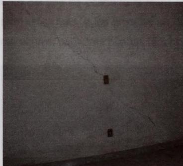
**Figura 20. Grieta por asentamiento de cimentación.**
