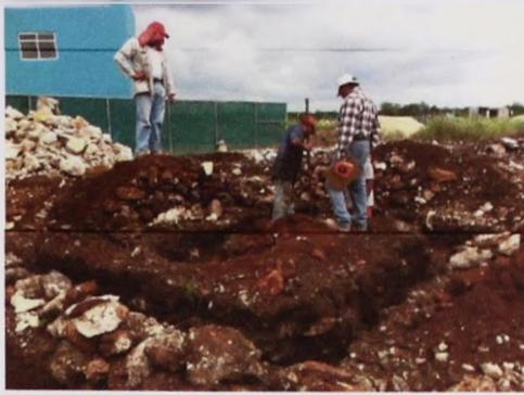
**Figura 15. Excavación y verificación del nivel de roca firme**
