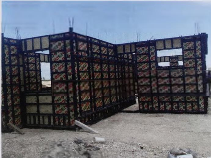
**Figura 36. Armado de molde para colado de muros**
