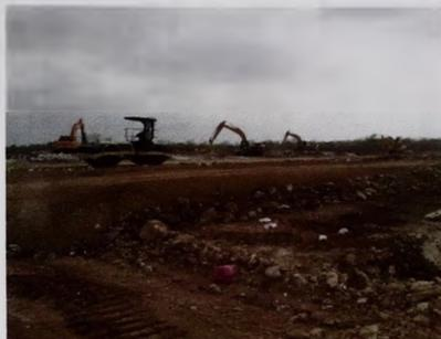
**Figura 29. Terraceerías para elaboración de plataformas de cimentación**
