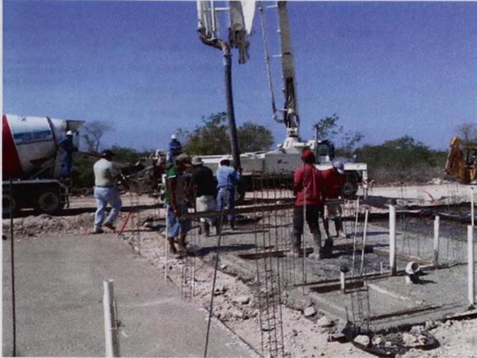
**Figura 35. Colado de losa de cimentación de viviendas**
