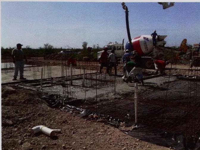
**Figura 33. Anclajes de cimentación**
