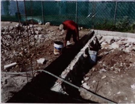
Imagen 19. Impermeabilización de cadena de cimentación de concreto.
