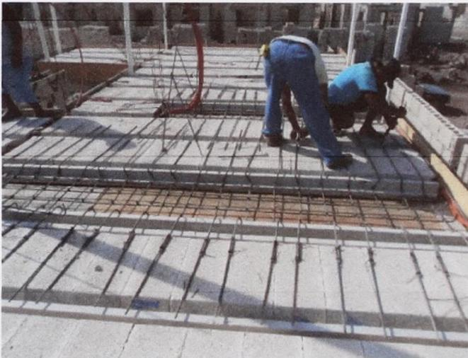
**Figura 25. Colocación del acero de refuerzo y de preparación de tuberías para instalaciones hidráulicas y sanitarias**
