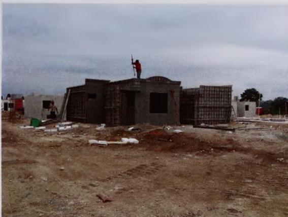
**Figura 38. Proceso de desmolde de muros**
