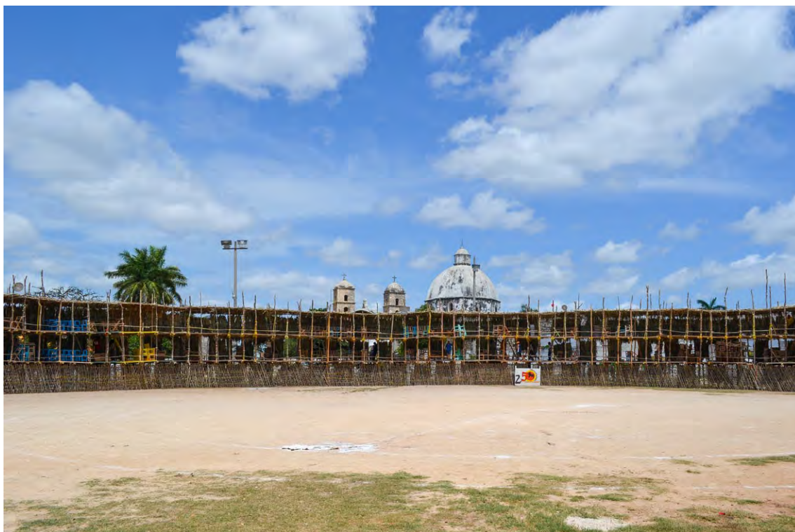
Figura 2 Espacio abierto con el tablado construido. Vista desde el interior. Hechelchakán, Campeche. Foto: Aurelio Sánchez, 2003.
