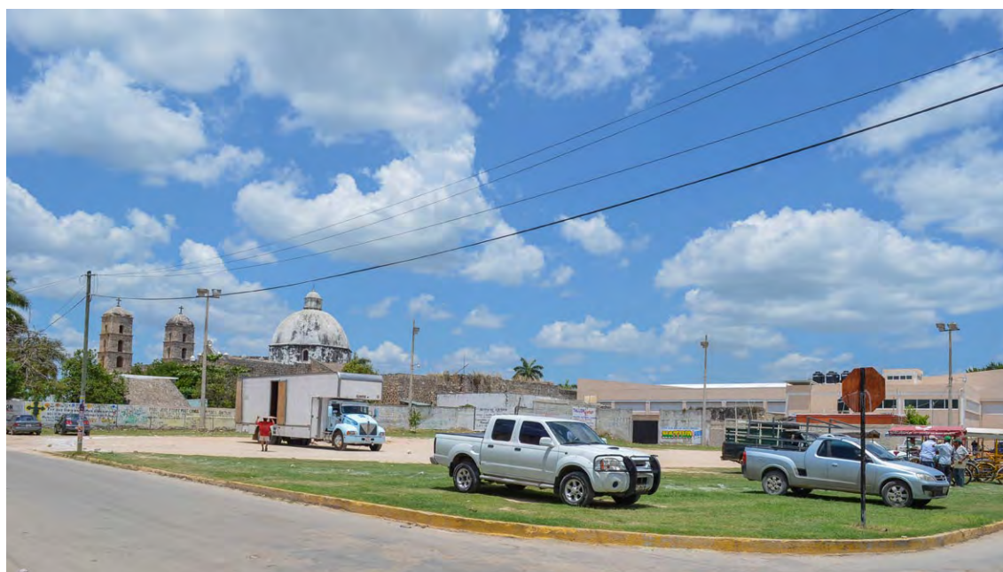
Figura 1 Espacio abierto donde se construye el tablado. Se puede apreciar el templo al fondo. Heclchakán, Campeche. Foto: Aurelio Sánchez, 2003.
