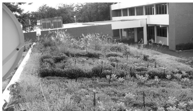
Figura 5. Cara norte del techo verde de 160 m 2 sobre la sala audiovisual 1 de la FIUADY.
