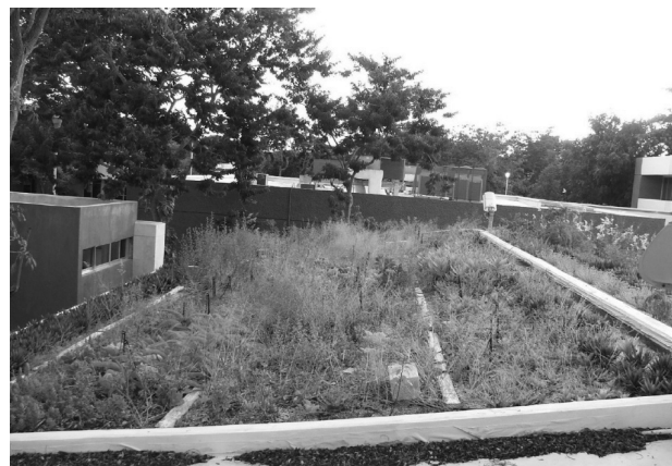
Figura 6. Cara sur del techo verde de 160m 2 sobre la sala audiovisual 1 de la FIUADY.
